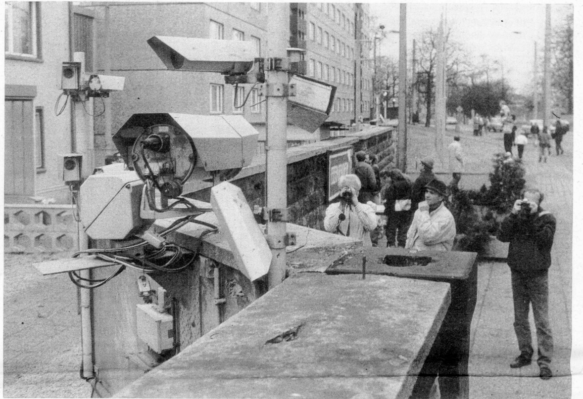
Dresden, Bautzener Straße
