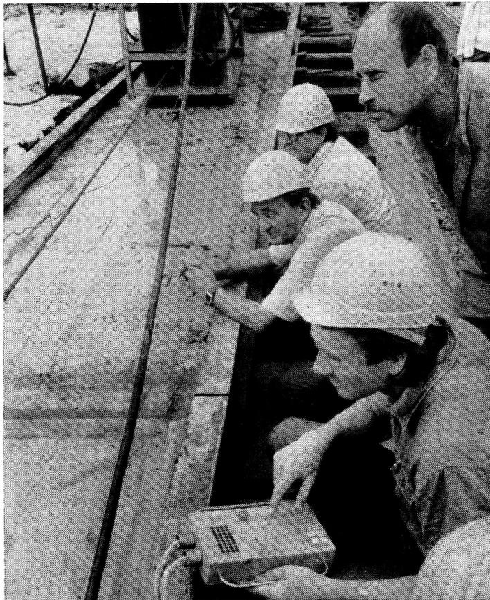
*Es ist ein spannender Augenblick, wenn nach exakter Vorbereitung Hunderte oder gar Tausende Tonnen schwere Bauteile mit Hilfe der Hochdruckfluidtechnik bewegt werden können. Hier kommt diese Technik bei der Demontage einer Brücke in der Berliner Leninallee zum Einsatz.*
