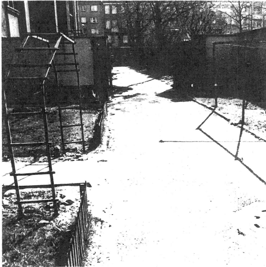
Umwehrungsmauer der UHA
