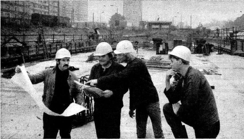
Die Genossen Rainer Fischmann und Siegmund Drescher aus dem VEB Verkehrsbau Berlin beraten mit ihren Kollegen Mario Otto und Heiko Meinka (v. l. n. r.) auf der Baustelle U-Bahn Linie E weitergehende Initiativen zur term in- und qualitätsgerechten Realisierung ihrer Aufgaben bei dieser wichtigen Verkehrslösung.
