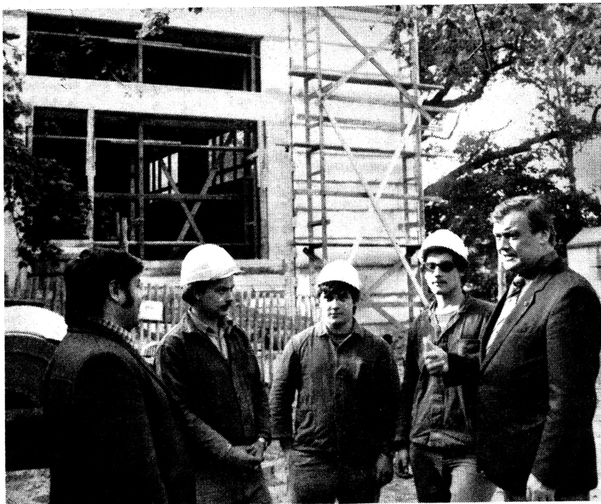
Der Bürgermeister von Bitterfeld, Genosse Klaus Barth (r.), im Gespräch mit Bauarbeitern an der Umformstation der Südtrasse des neuen Fernwärmerrings der Stadt.
