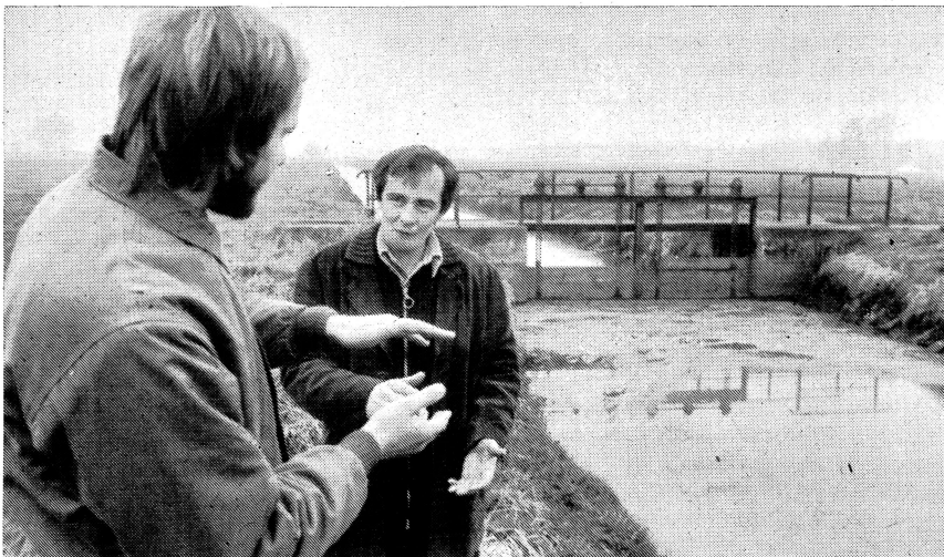
Genosse Bernd Steger, Autor des nebenstehenden Beitrages (r), überprüft gemeinsam mit dem Brigadier für Beregnung Waldemar Morling die Winterfestmachung der Stauanlagen der LPG (P) Cottbus-Nord/Dissen.
