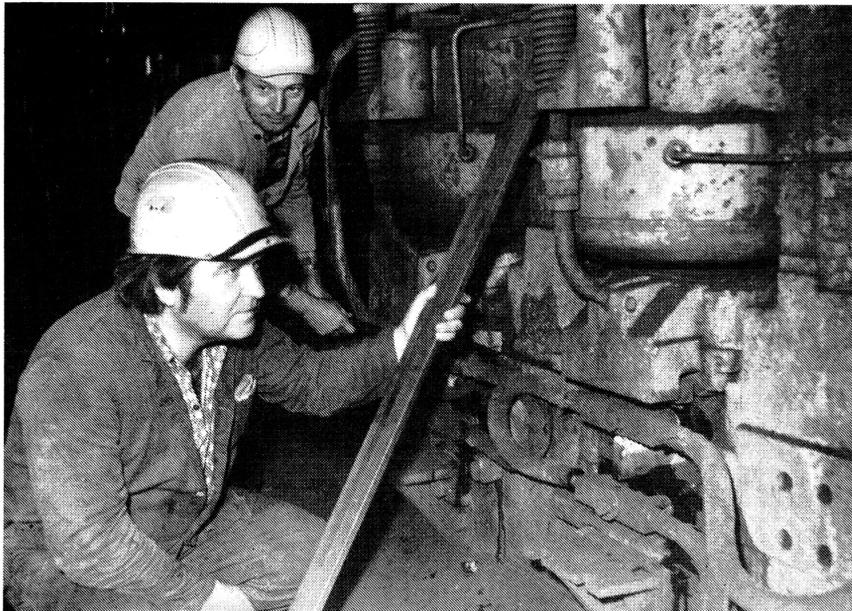
Die Genossen Arnold Pedde, 1. Formleger, und Rudolf Thieme, 1. Presser, aus der Brikkettfabrik Witznitz im VEB Braunkohlenwerk Borna beim Formwechsel an einer Brikkettpresse.
