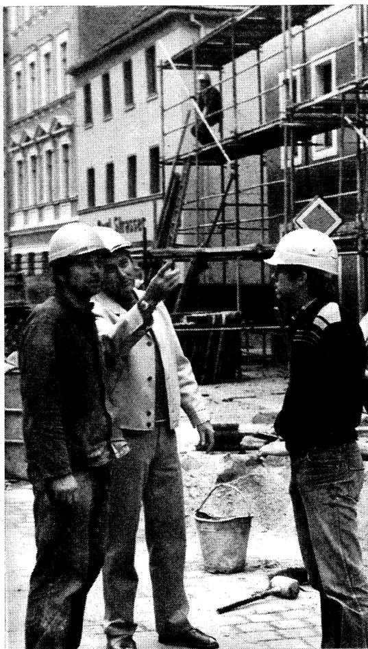
Komplexe Rekonstruktion in der Torgauer Leninstraße. Auf unserem Foto (v. r. n. l.) die Genossen Gründler, Bereichsbauleiter, Mikforow, Parteisekretär, und Linsener, Parteileitungsmitglied aus dem Kretebaubetrieb.
