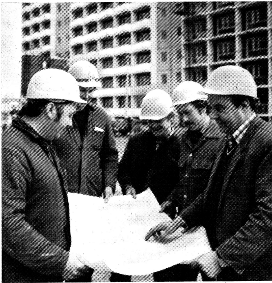
Die regelmäßigen gemeinsamen Beratungen der Leiter mit ihren Kollektiven auf den Baustellen des VEB WBK Erfurt ist ein Unterpfand für gute Organisation und sinkenden Aufwand. Auf unserem Foto: Taktstraßenleiter Günter Schmidt (r.) im Gespräch mit Kollegen seines Kollektivs Foto:Werkfoto
