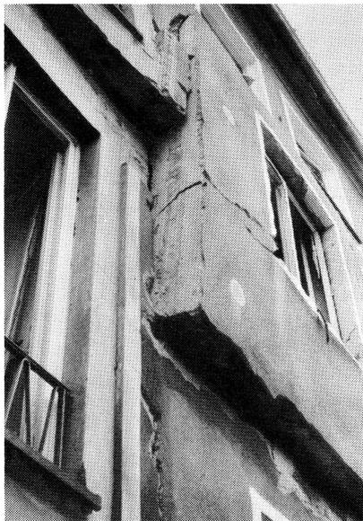
Bild 78 Raumexplosion (Gas) — Beschädigung an der Vorderfront des Hauses
