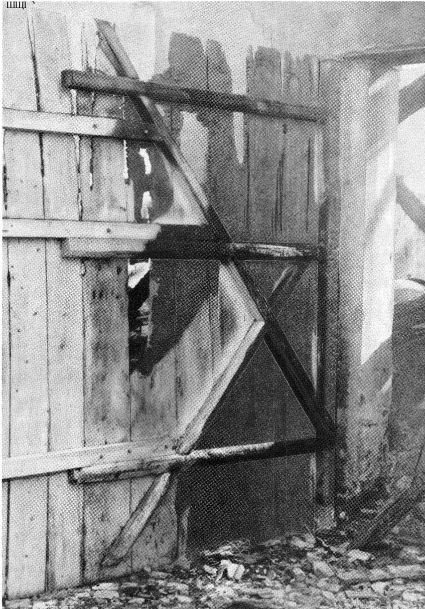
Bild 22 Verbrennungserscheinung an einer Holztür
