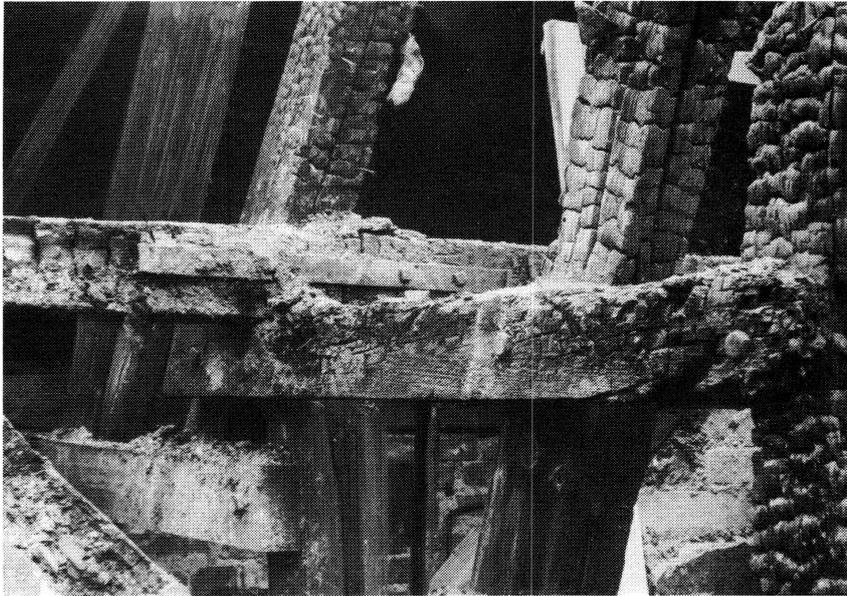
Bild 1 Abbrand an dem Gebälk eines Dachstuhls
