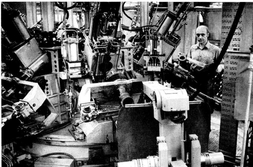
Genosse Ludwig Gotthold überwacht und bedient einen von drei im Karosserierohbau des VEB Sachsenring-Automobilwerke eingesetzten Roboter.
