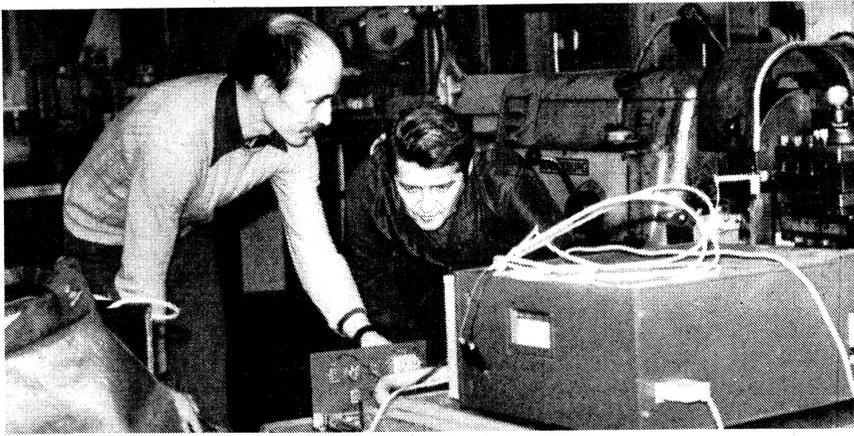
Ein vom Dipl.-Physiker Jörg Holzvoigt (Foto links), Entwicklungsingenieur im Stammbetrieb des VEB SKET Magdeburg, gebautes Gerät zur Automatisierung der Verschleiß-Meßtechnik für spannende Werkzeugmaschinen wird in Zusammenarbeit mit Angehörigen der Technischen Hochschule Magdeburg erprobt und für den Schnittwertspeicher genutzt. Foto: Trunert
