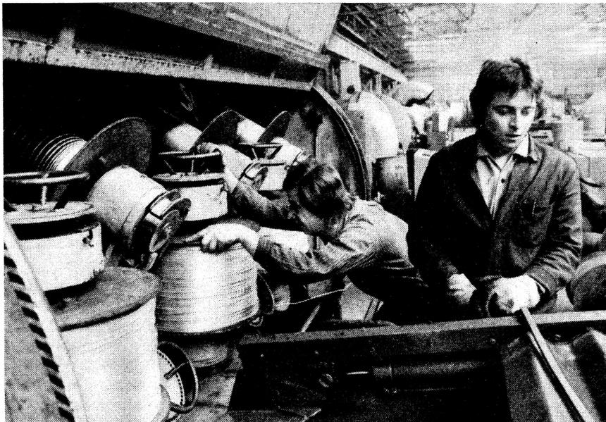
Witterungsbedingte Produktionsausfälle werden von den Werktätigen des Berliner Kabelwerkes Oberspree wettgemacht. Genosse Detlef Rosengart und Peter Höftmann (r.) von der Jugendbrigade „Wilhelm Liebknecht“ beim Wechseln von Kabeltrommeln an einer Drahtverseilmaschine.
