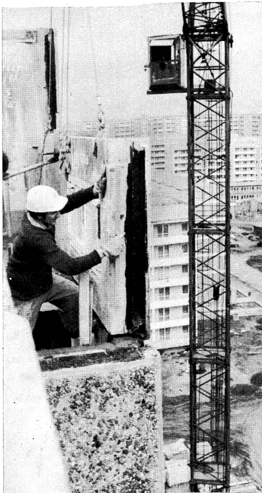
Wohnungsneubaugebiet Magdeburg/Nord. Die Montagebrigade Radtke beim Setzen einer Außenwand.
