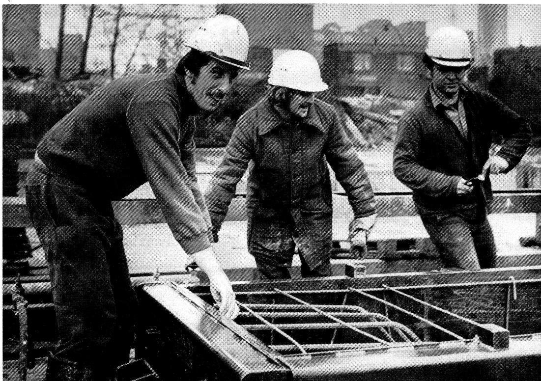
Der Jugendbrigadier Genosse Claus-Dieter Gast mit seinen Kollegen Reinhard Schneider und Harry Voss (v.l.) bereiten die Produktion einer Deckenplatte für den Zweikammerkollektor vor. Ihre Betonfertigteile sind eine wesentliche Voraussetzung für die Fließfertigung im Tiefbau.
