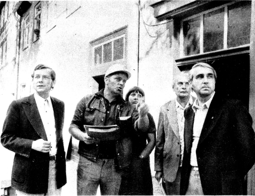
Genosse Herbert Wolf (r.), Stellvertreter des Bürgermeisters von Pößneck, überzeugt sich regelmäßig, wie die Altbauten der Kreisstadt zügig modernisiert werden. Bauleiter Heiner Wöckel (2. v. l.) berichtet, an Ort und Stelle dabei sind der Abgeordnete Wilhelm Groß und die Mitarbeiter des VEB Gebäudewirtschaft Margot Kießling und Volker Heber (v. r. n. l.)
