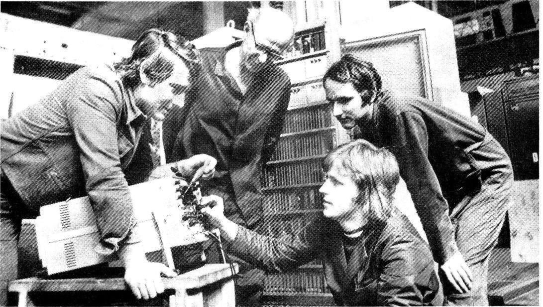
**Die vorbeugende Instandhaltung der -hochproduktiven Maschinen und Anlagen im VEB Maschinen- und Apparatebau Grimma ist für die Steigerung der Arbeitsproduktivität von großer Bedeutung. Auf unserem Bild warten Helmut Stephan, Leiter der NC-Technik, Werner Fritzsche, Bohrwerksdreher, Günter Wilms, NC-Wartungsmechaniker, und Wolfgang Krause, NC-Wartungsingenieur (v. l. n. r.) eine hochproduktive Numerik-Maschine.**
