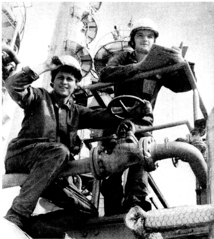
Wie überall in der CSSR, stehen auch in der Erdölraffinerie KRALUPY die Mitglieder des SSM im Wettbewerb zum XV. Parteitag der KPTsch. Unser Bild zeigt Josef Stross und Miroslav Cermak beim Kontrollieren von Ventilen.
