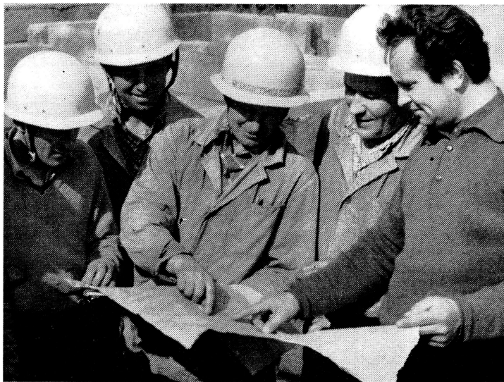
Tausende von modern ausgerüsteten Wohnungen schufen die Bauarbeiter in Vilnius. Foto: Zentrales Haus derDSF
