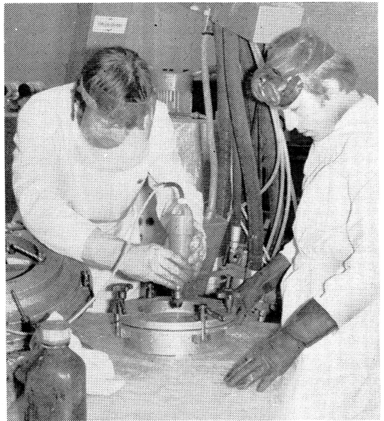
Die jüngste Produktionsstätte der Turbowerker ist die Polyurethan-Schäumerei. Im Bild Genosse Bernd Fichter (r.) und Kollege Frank Schulz beim Schäumen von Hauben für Dachventilatoren.
