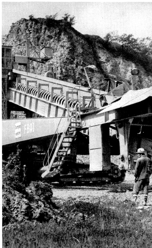
Erstmalig wurde im vergangenen Jahr in der Zementindustrie eine 460 Tonnen schwere und 40 Meter breite fahrbare Brechanlage im Rüdersdorfer Kalkstein-Tagebau ohne Demontage an den neuen Arbeitsort transportiert.
