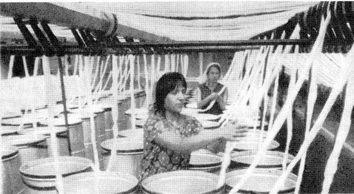
Im Werk Lugau des VEB Glauchauer Kammgarnspinnerei haben die Werktätigen bereits Ende 1973 begonnen, nach 74er Kennziffern zu arbeiten. Die Spinnerinnen des Werkes — unser Bild zeigt Gudrun Richter am Flyer beim Einziehen des Streckbandes — arbeiten nach dem Grundsatz der sowjetischen Neuerer Smirnow und Belowa: „Keiner ist so gut, um nicht noch besser werden zu können!“
