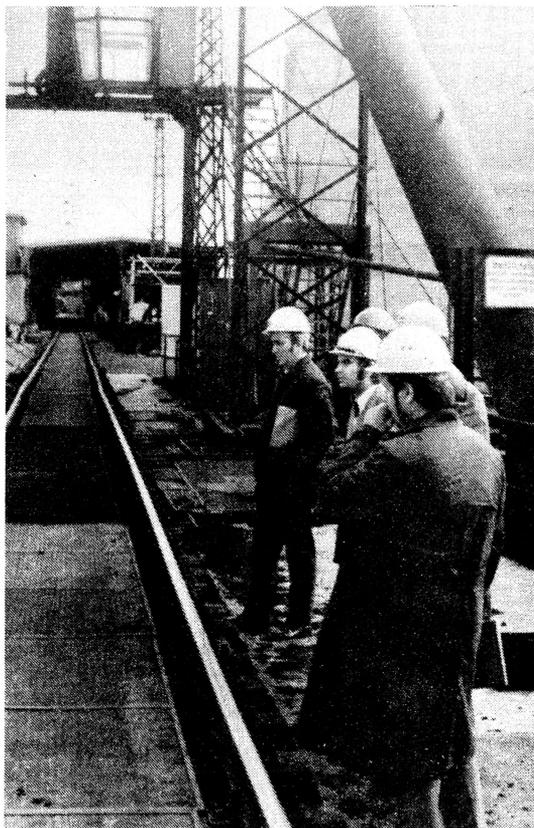
Ein Flugzeug-Strahltriebwerk leistet im VEB Kraftwerke „Artur Becker“ Trattendorf gute Hilfe im harten Winterdienst. Ein Heißgasstrom wird in die Waggons gedrückt, erwärmt die festgefrorene Kohle und reißt sie in die Bunker. Die neue Anlage (unser Bild: letzte Prüfung vor dem Winte#) wurde von Werk tätigen aus Trattendorf projektiert, konstruiert und errichtet.
