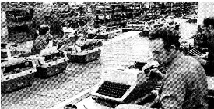
Endmontage der mechanischen Schreibmaschine im VEB Optima Erfurt. Hier arbeitet die Brigade „Juri Gagarin“, die bereits dreimal mit dem Staatstitel ausgezeichnet wurde (u. B.). Die Brigade verpflichtete sich, in diesem Jahr 60 Schreibmaschinen in guter Qualität zusätzlich zum Staatsplan zu fertigen und die Ausschuß- und Nacharbeitungskosten um fünf Prozent zu senken.
