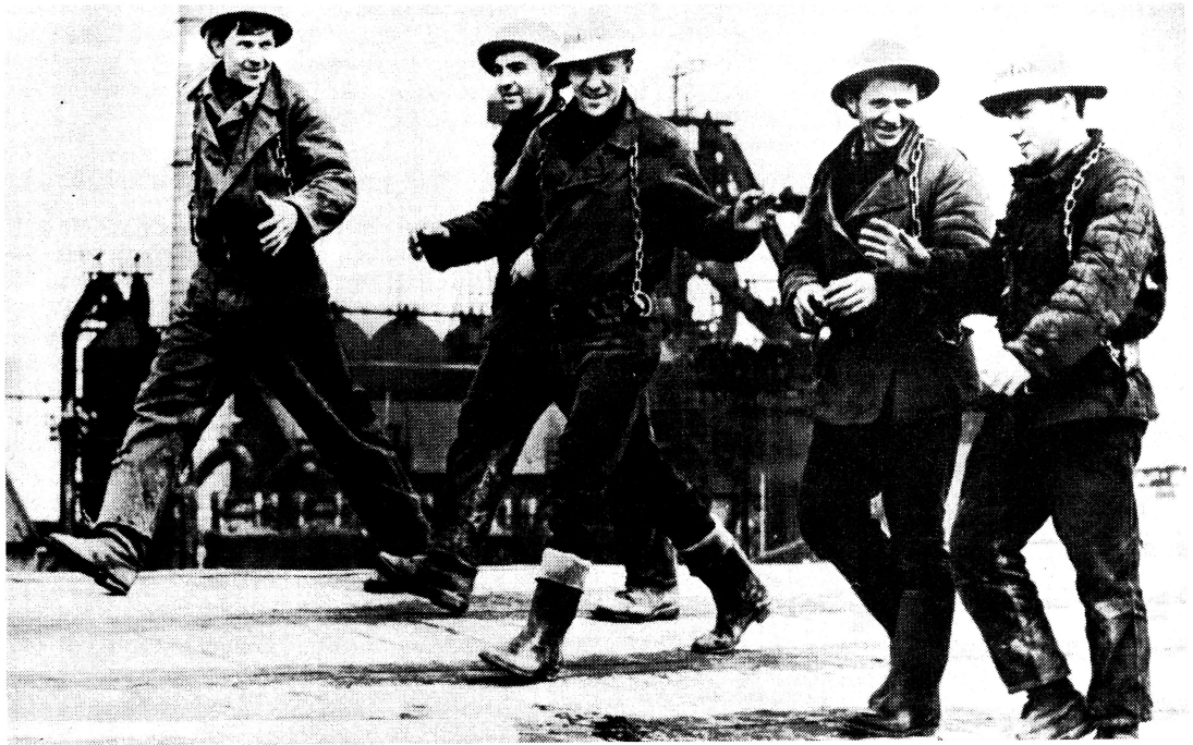
Die Montagebrigade Sergejew ist eine der besten Brigaden, die im Westsibirischen Hüttenkombinat in Nowokusnezsk an einem Hochofen mitgebaut hat, dessen Fassungsvermögen 3000 Kubikmeter beträgt.
