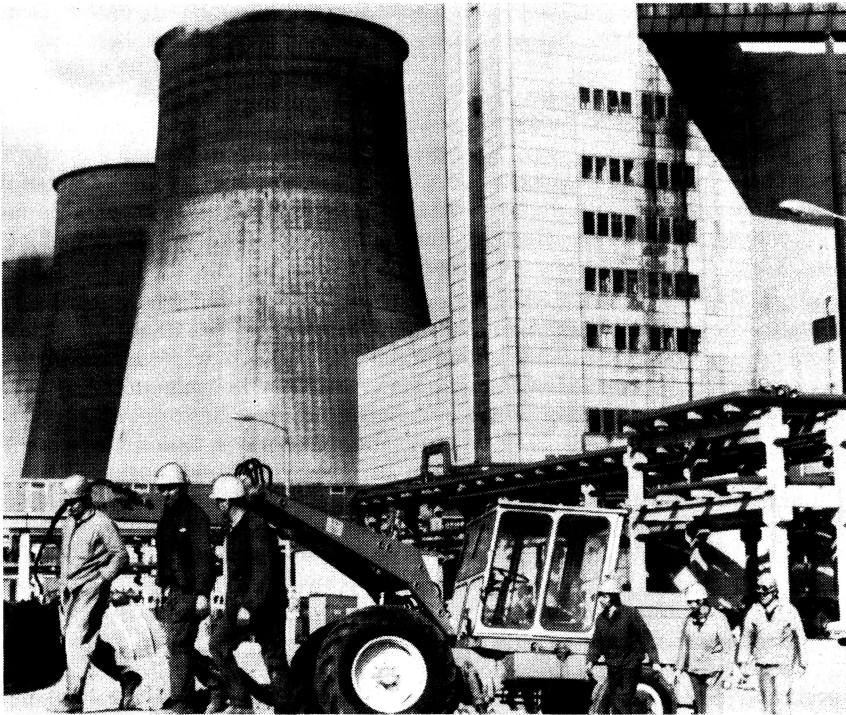
Kraftwerk Boxberg — Großbaustelle der Deutsch-Sowje- tischen Freund- schaft.
