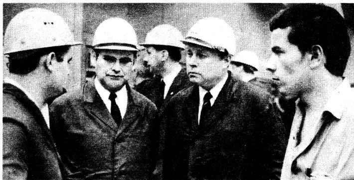
Der Kandidat des Politbüros der SED, Genosse Walter Halbritter (2. v. l.) und der Minister für Bauwesen, Genosse Wolfgang Junker (3. v. l.), im Gespräch mit Arbeitern in der Schaltwarte für die Drehöfen 4 und 5 des Zementwerkes Bernburg IV.
