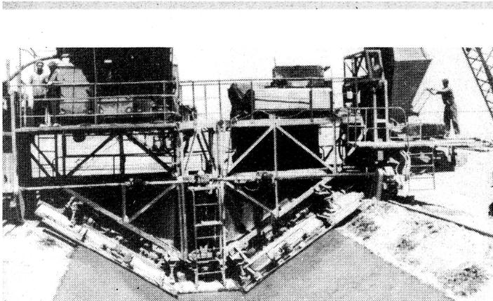
Im Nordwesten der Steppe in der Usbekischen SSR entstehen neue Staatsgüter, die zugleich umfangreiche Kanalbauten erfordern. Unser Bild zeigt eine Kanalbaumaschine, die von Mitarbeitern eines Forschungsinstitutes entwickelt wurde, im Einsatz. Sie begründet die Wände des ausgeschachteten Kanalbettes und verkleidet sie mit Beton. In einer Schicht betoniert diese Maschine 150 Meter Kanal.
