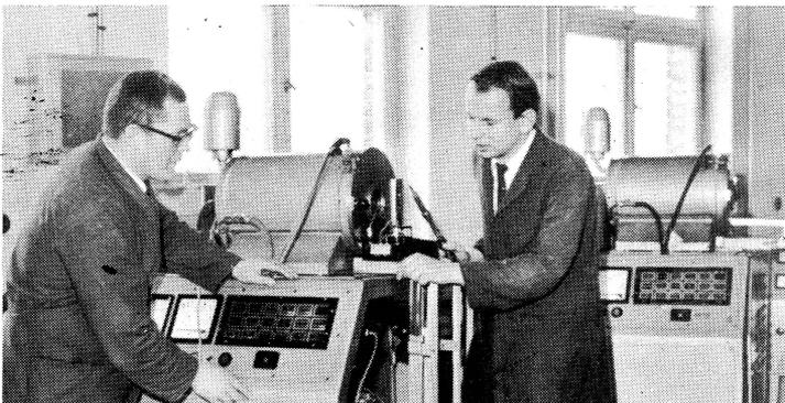
Die Ingenieure Günther Richter (links) und Siegfried Kaim aus dem VEB „Carl von Ossietzky“, Teltow, erproben eine neue Bedampfanlage in der Metallschichtfertigung»
