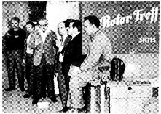
Roter Treff in einem Meisterbereich der Stationären Fertigung. Foto: Albert
