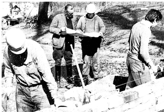
Mitglieder der Kooperationsgemeinschaft „Berliner Norden“ und Schüler der Erweiterten Oberschule „Geschwister Scholl“ in Bernau helfen beim Bau einer neuen Turnhalle.
