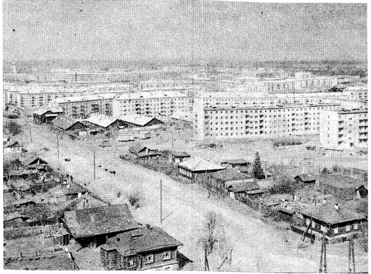
Das neue Swerdlowsk. Hier wird vom Häuserbaukombinat Swerdlowsk das neue Stadtviertel B „Pionier“ errichtet.
