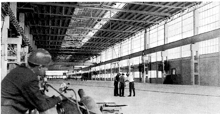
Die aus Metalleichtbauelementen gefertigten Vollwandrahmenhallen finden vorwiegend in der Industrie als Produktionsstätten, aber auch in der Lagerwirtschaft Verwendung. Die großen Fensterflächen bieten gute Lichtverhältnisse in den Hallen. Foto: Petri
