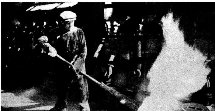
Es war eine körperlich sehr schwere Arbeit, die Kammerdeckel eines Vertikalkammerofens manuell zu bedienen. Die Genossen und Kollegen der Abteilungen Technik und Technische Entwicklung des VEB Energieversorgung Halle, die schon viele technische Neuerungen durchsetzten, ließen auch hier den wissenschaftlich-technischen Fortschritt Eingang finden;...
