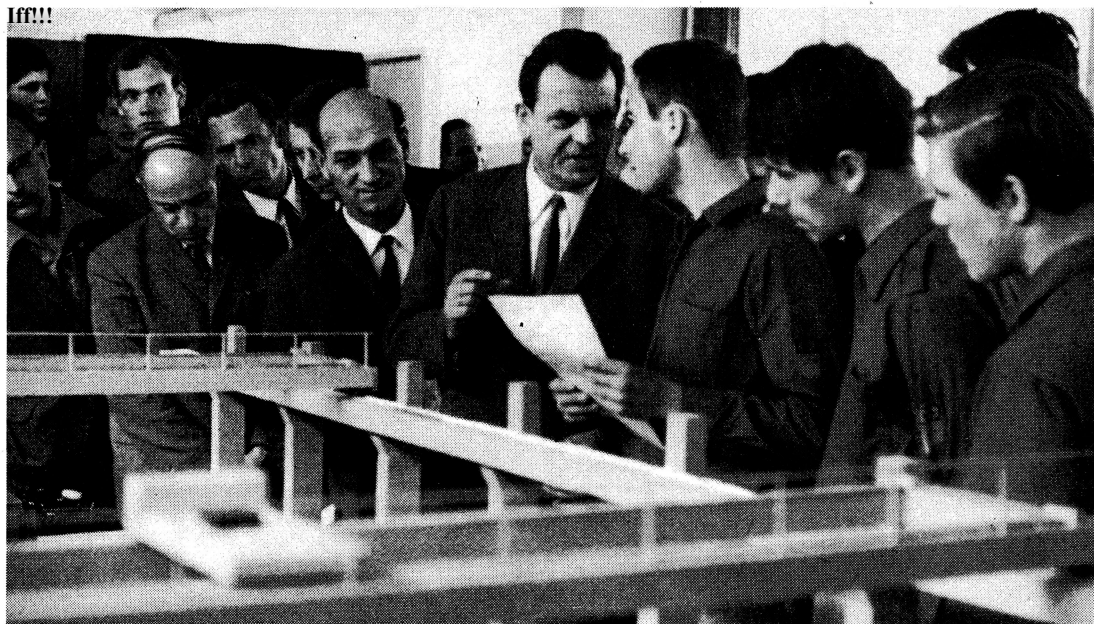
Junge Neuerer, Bauarbeiter von der Großbaustelle Halle-Neustadt, erläutern vor den Direktoren des WBK Halle ein Modell, das von ihnen auf der Betriebsmesse der Meister von morgen ausgestellt wurde.
