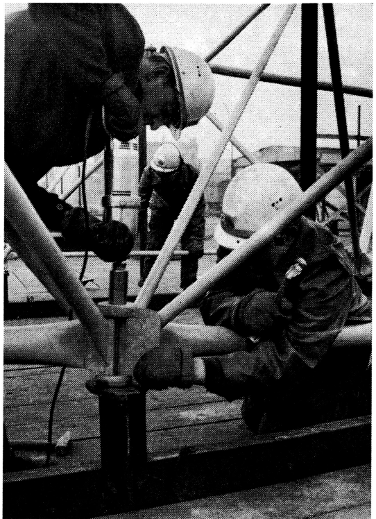
Montage von Metall-Leichtbau-Dachsegmenten
