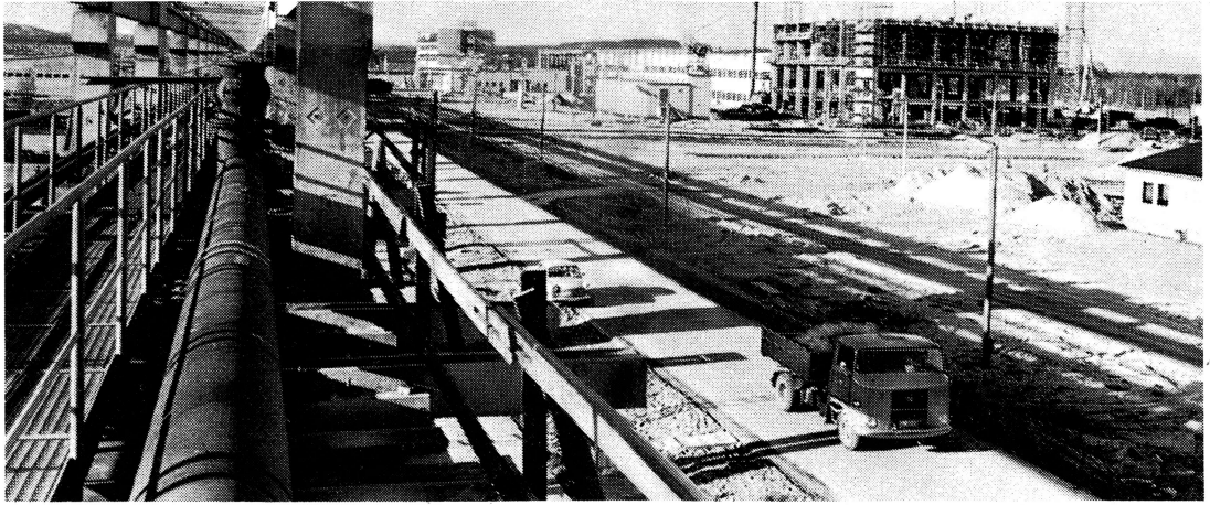
Termingerecht beendet haben die Bau- und Montagearbeiter des BMK-Ost die Montage des fasertechnischen Teiles und des Verwaltungsgebäudes auf der Großbaustelle WOLPRYLA des VEB Chemiefaserwerk „Friedrich Engels“, Premnitz. Foto: MV. Drygalla
