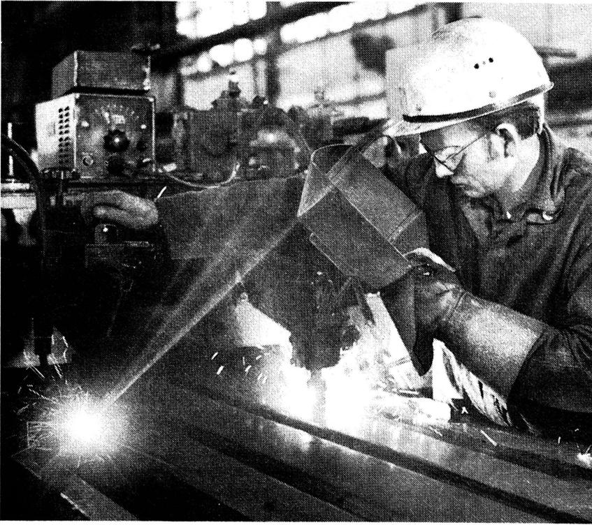
Schweißer Kurt Mattner aus dem VEB Stahlbau Plauen bei der Arbeit an einer automatischen Schweißstraße. Dieses Schweißportal ist das Resultat gemeinsamer Arbeit von Ingenieuren und Arbeitern. Der Automat ermöglicht eine Steigerung der Produktivität gegenüber dem Handschweißen um ein mehrfaches.
