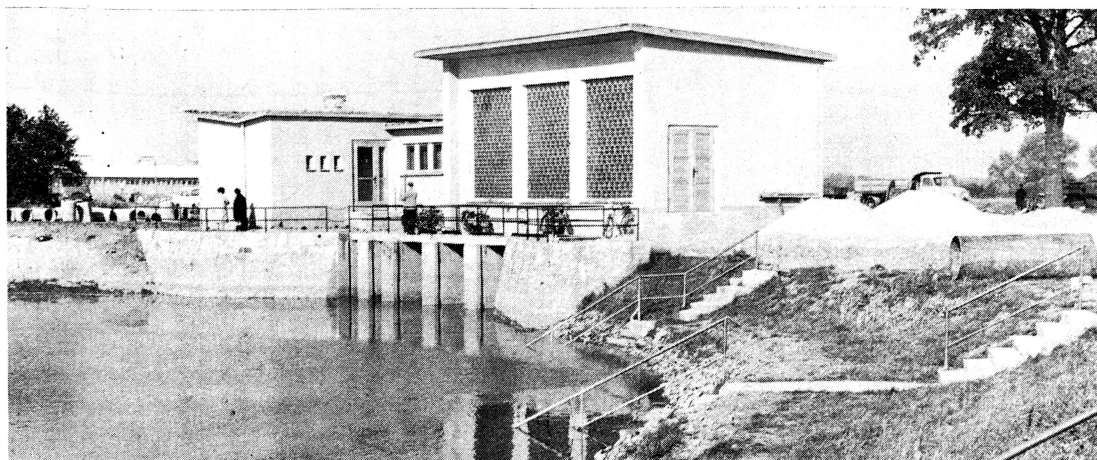
Komplexe Be- und Entwässerungsmaßnahmen der Kooperationsgemeinschaft „Heideck“, Kreis Jessen, erhöhen die Bodenfruchtbarkeit und steigern die Erträge auf dem Acker und dem Grünland. Unser Bild zeigt: Ein neues Schöpfwerk der Kooperationsgemeinschaft „Heideck“.
