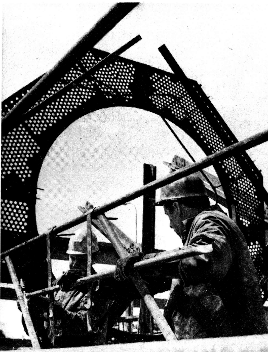
Kranmontage in Eberswalde
