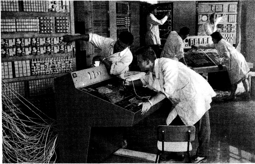
Montage der Kontroll- und Steuerungsmaschinen „Pusk-3“, mit der z. B. Fertigungsprozesse in Hütten-, Chemie- und Papierbetrieben gelenkt werden können.
