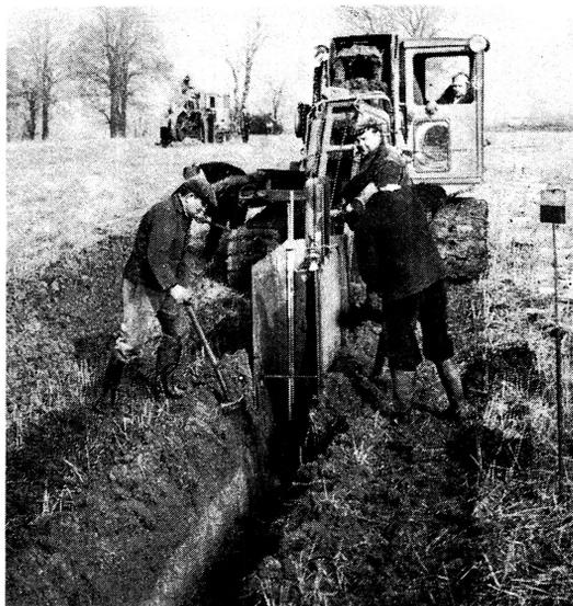
Im VEG Tützpatz, Kreis Altentreptow, wird durch umfangreiche Meliorationsarbeiten brachliegendes Land nutzbar gemacht. Unser Bild zeigt: Sowjetische Spezialdrainagemaschinen vom Typ ETN 171 des VEB Meliorationsbau Neubrandenburg im Einsatz.
