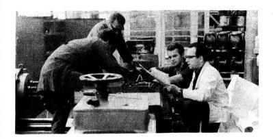
Bessere Auslastung der Maschinen, ein Hauptanliegen der Werktätigen im VEB Geräte- und Reglerwerk Teltow. Konstrukteur Hans Simon, Einrichter Helmut Kundlacz (rechts) und die Werkzeugmacher Rudi Hinze und Dieter Schulz (links) beim Umrüsten der Einheitsbohrmaschine.
