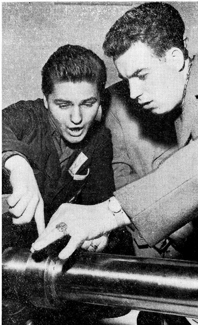
*Im Metallzirkel des Klubs Junger Techniker aus dem VEB Meßgeräte und Armaturenwerk „Karl Marx“ Magdeburg wird eine Vorrichtung zum Drehen von Zylindern mit Schneidkeramik ausprobiert.*
