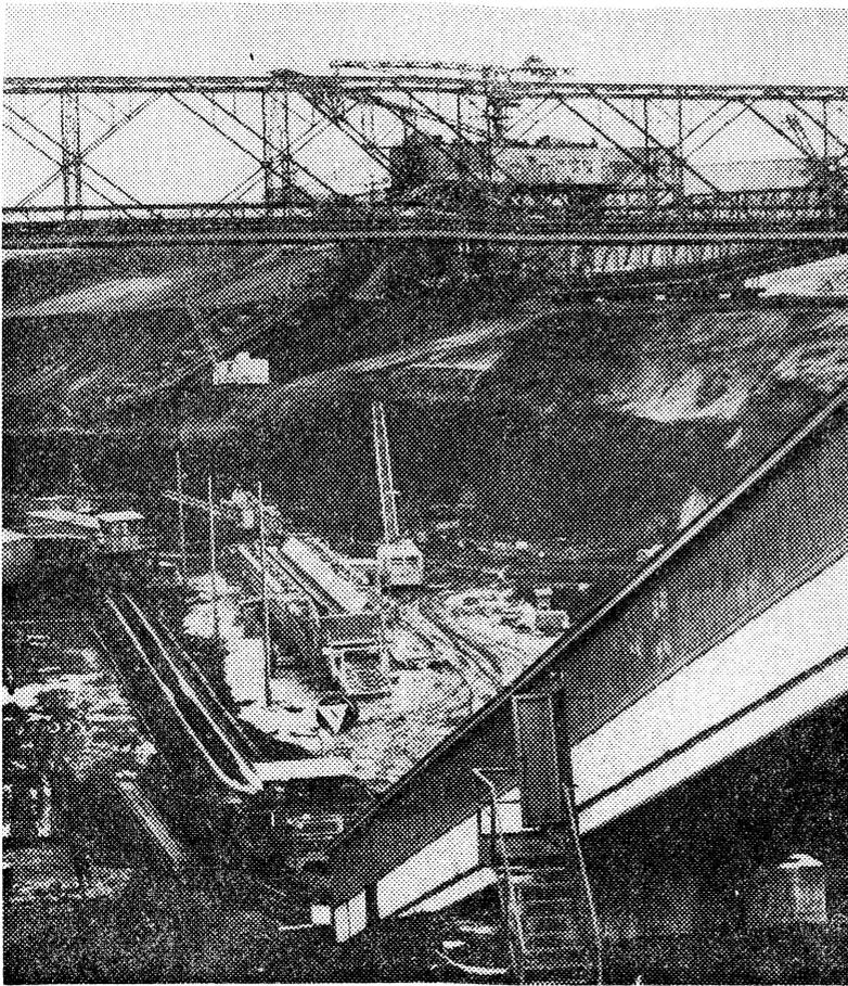
*In das sich ständig vergrößernde Kombinat Schwarze Pumpe und das Kraftwerk Trattendorf im Bezirk Cottbus werden nach Inbetriebnahme dieser 1,5 Kilometer langen Bandanlage des Tagebaues Burghammer täglich bis zu 25 000 Tonnen des schwarzen Goldes gefahren*
