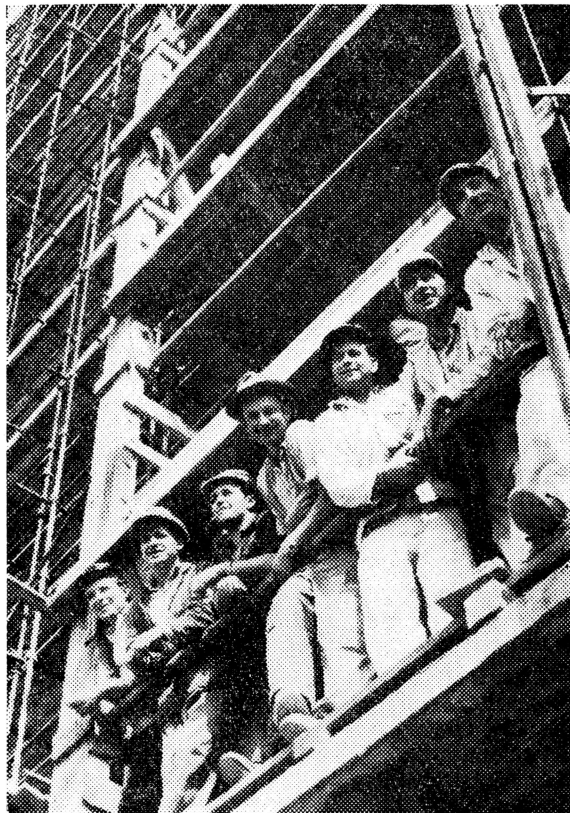
Foto; Zentralbild Baustelle Kraftwerk 111 in LübbenauM. Drei Tage früher als vorgesehen wurde die Mauererbrigade Hämsch mit dem Abputzen des Westgiebels am Maschinenhaus fertig
