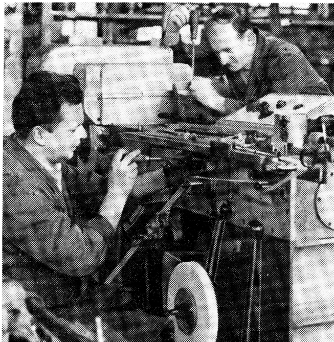
Foto: Zentralbild Das erste „Q“ erhielt der VEB Tabakuni. Unser Bild zeigt den Elektroinstallateur Erhard Meier (links) und den Technologen Karl Lippert bei der Endmontage der Filter Stabmaschine „FS“, der dieses höchste Gütezeichen der DDR verliehen wurde
