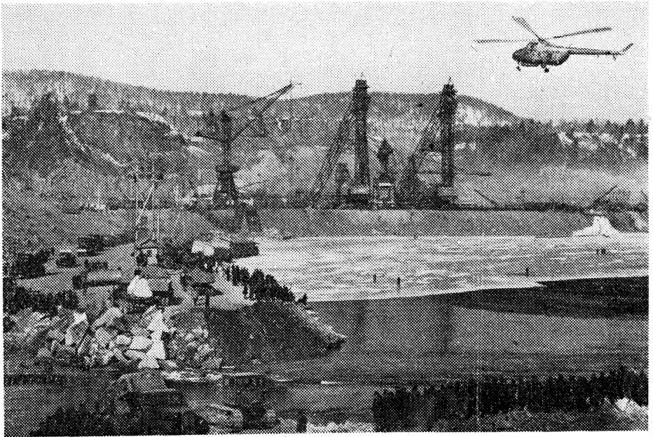
Auf der Baustelle des Krasnojarsker Wasserkraftwerks
